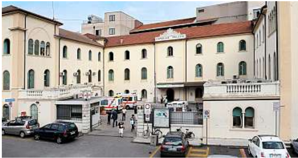
L'ospedale di Bussolengo dove è stato eseguito l'intervento di ricostruzione
